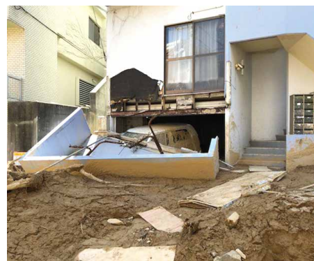
神戸市灘区篠原台の土砂崩れ現場
